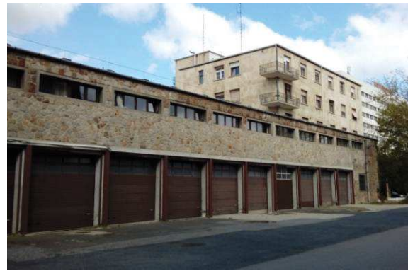
A Tűzoltóság épülete a Tas vezér utca Diószegi út kereszteződésénél (1. tömb)
