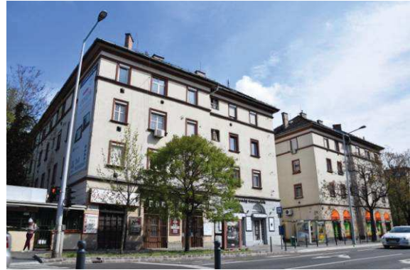
Bocskai úti társasház földszinti szolgáltató funkciókkal (3. tömb)
