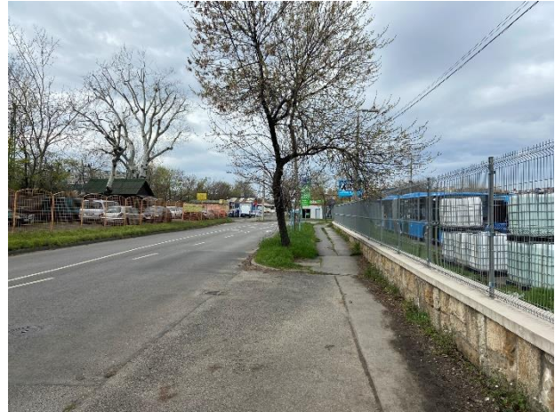
7.6. ábra: A Hamzsabégi út a Kelenföldi buszgarázs melletti szakaszon (saját készítésű fotók)
