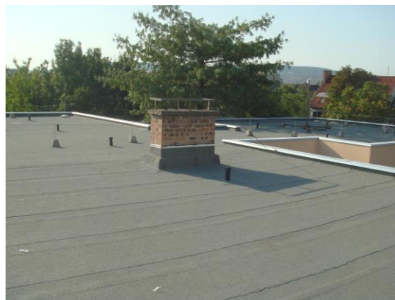
Felújított, hőszigetelt tető
