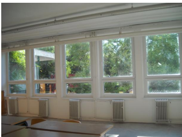
Új műanyag nyílászárók
