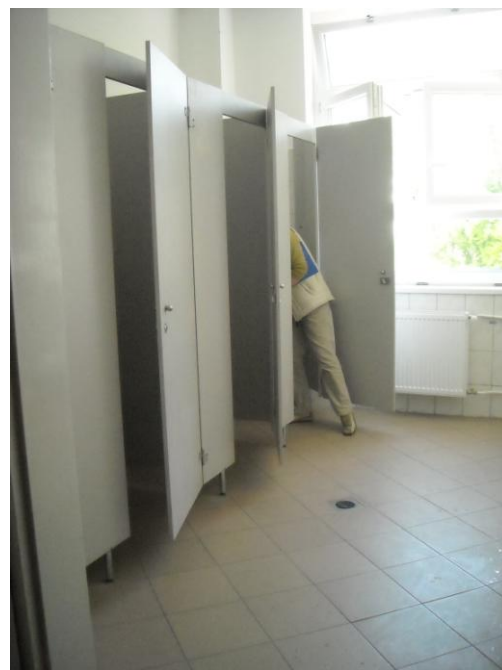
Felújított WC vizesblokk
