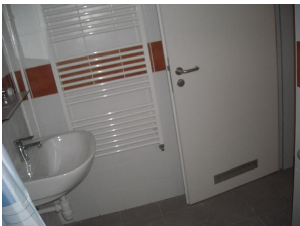
Fürdőszobák felújítás után (fszt. 16.)
