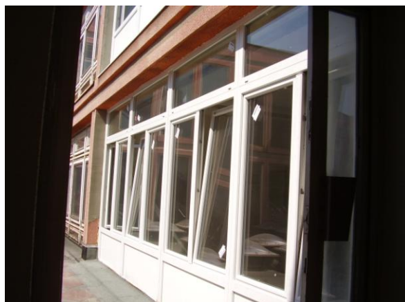
Új műanyag nyílászárók
