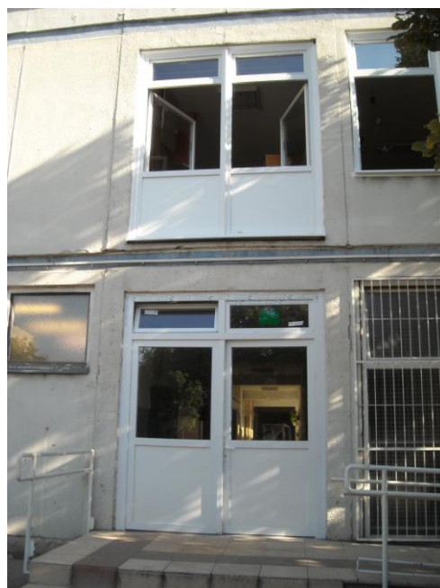
Új műanyag nyílászárók
