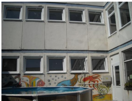
Új műanyag nyílászárók
