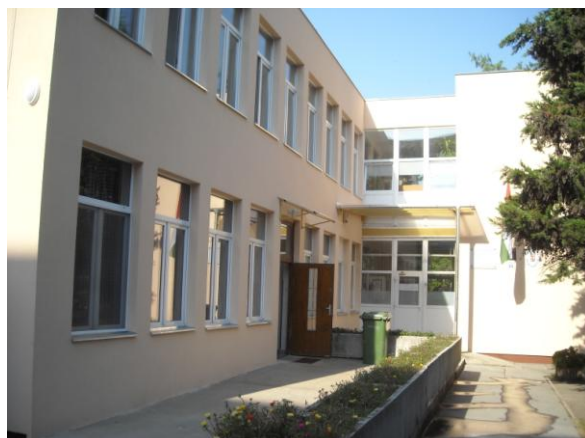
Hőszigetelt bejárati homlokzat új előtetővel
