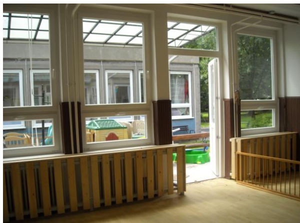
Új nyílászárók és radiátorvédők
